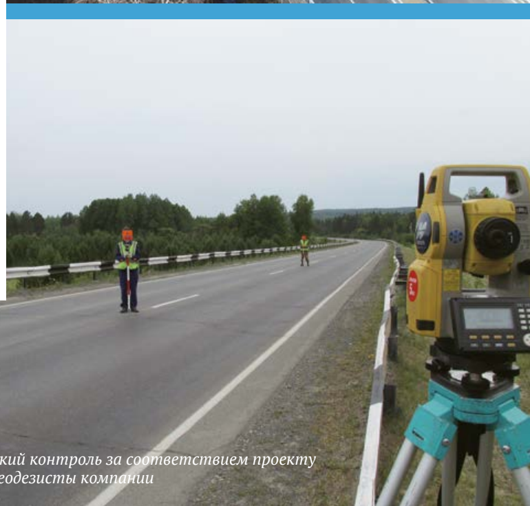
2017 г. После капитального ремонта по проекту АО МК «ИНДОР» пропускная способность Ангарской объездной увеличилась практически вдвое
