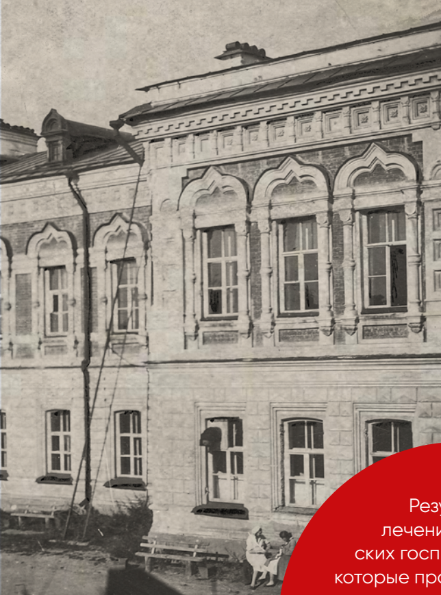
Здание Иркутского Физиотерапевтического института Эвакогоспиталь № 934, принявшего первую группу раненых в конце 1941 г. Ныне здесь курорт «Ангара»
