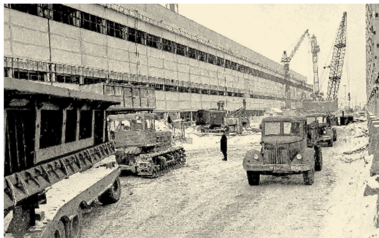
Строительство корпусов БРАЗа
