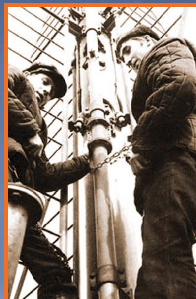
Монтаж передающей антенны
