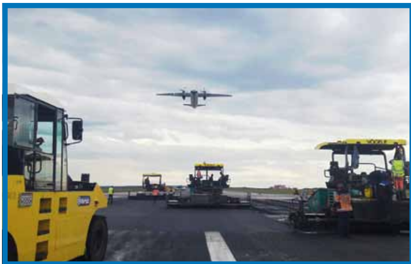
Реконструкция ВПП аэропорта «Иркутск». Здесь также применялись новые технологии
