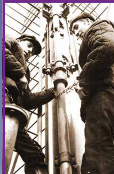
Монтаж передающей антенны
