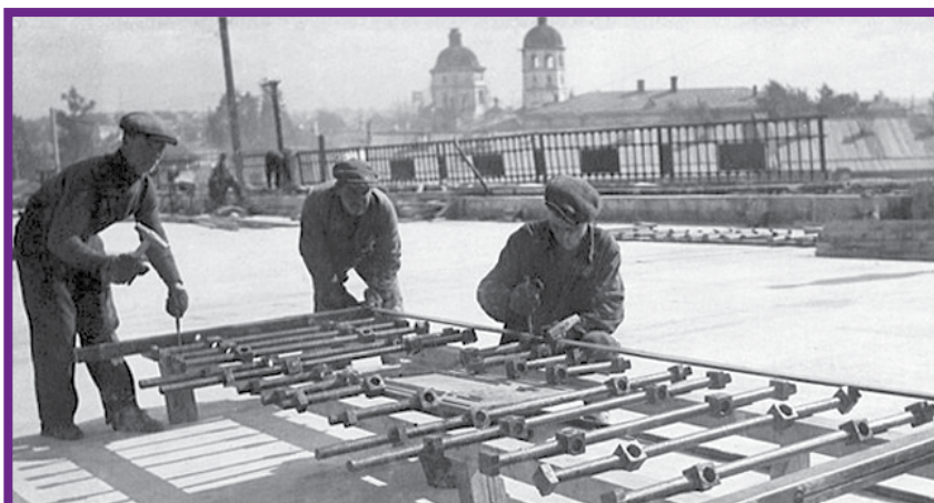
Монтаж перил. Сентябрь 1936.
