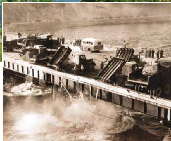
При строительстве Братской ГЭС применялись уникальные технологии
